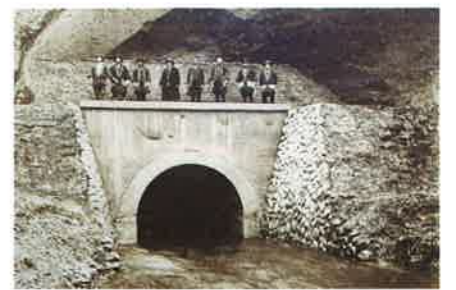
稲生川普通水利組合によるコンクリート巻き立て改修工事後の天狗山トンネル出口(昭和4年)
