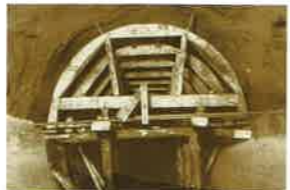
倉手隧道工事コンクリート打ち込み準備の様子
