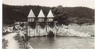
国営による改修前の木造の取水門
