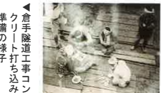
倉手隧道工事コンクリート打ち込み準備の様子
