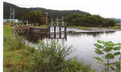
奥入瀬川から稲生川への取水門
