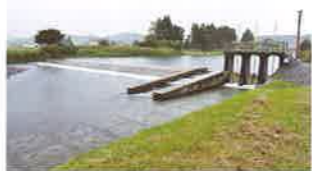
コンクリート固定堰となった現在の頭首工
