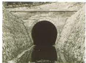
倉手隧道出口と出口部分のコンクリート巻き立ての様子
