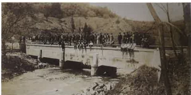
昭和8年の改修でコンクリート製の水路橋に
