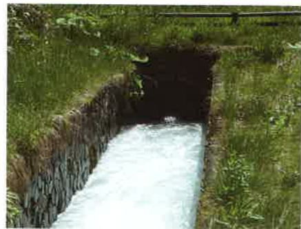
鞍出山トンネル入口
