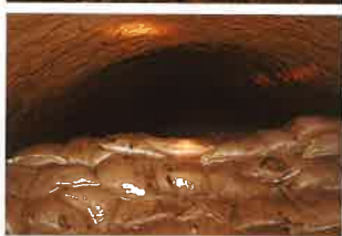
鞍出山トンネル内部にある、手掘りの掘削痕を保存する場所
