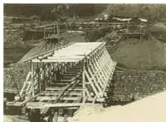
昭和18年水路橋工事中
