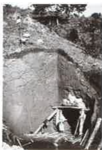
倉手隧道の工事の様子
