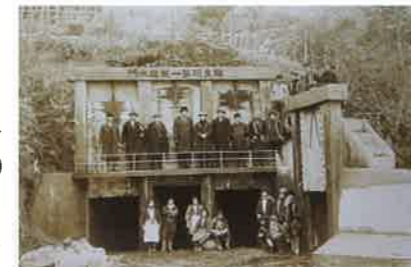
稲生川普通水利組合により改修された天狗山トンネル入口(昭和8年竣工当時)
